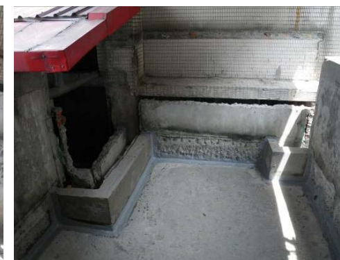
新設墩座及原防水層搭接
